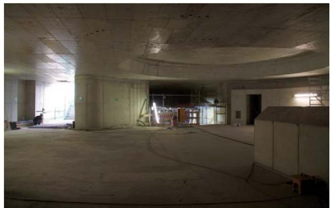
Unter der Fahrebene wird eine weitere Ebene angelegt, die als Kabelkanal dient. Zudem werden Betriebsräume errichtet. Der Schlitzwandkasten, in dem die Haltestelle gebaut wird, ist kleiner konzipiert als die runde Verteilerebene unterhalb der Platzfläche des Alter Markt. Teilbereiche der Schlitzwand werden daher im oberen Bereich abgebrochen und die Fläche für die Verteilerebene auf die notwendige Größe erweitert.
