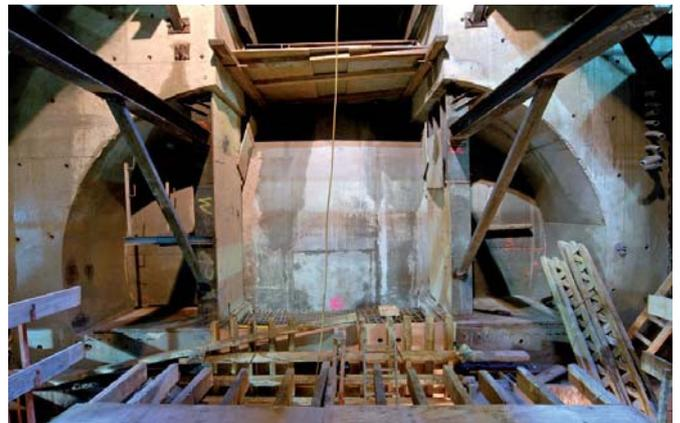
Um eine Verbindung zwischen der späteren Haltestelle und den Tunneln herzustellen, in denen die Bahnen fahren, werden das Erdreich und das darin befindliche Grundwasser vereist. In dem Bereich zwischen Schlitzwand und Tunnelröhre werden doppelwandige Rohre verlegt. Durch sie fließt minus 35 Grad kalte Sole, die Umgebungswärme aufnimmt, zurück in die Kältemaschine geleitet und dort wieder heruntergekühlt wird. Auf diese Weise entstehen Eiswände, die mindestens 1,20 Meter stark sind.
