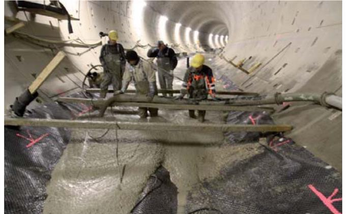
Nachdem diese „Querschläge“ fertig sind, werden die Rohbauarbeiten zur Herstellung der Haltestelle fortgesetzt. In die Tunnelröhren West und Ost werden Bahnsteige und Gleistragplatten gebaut.
