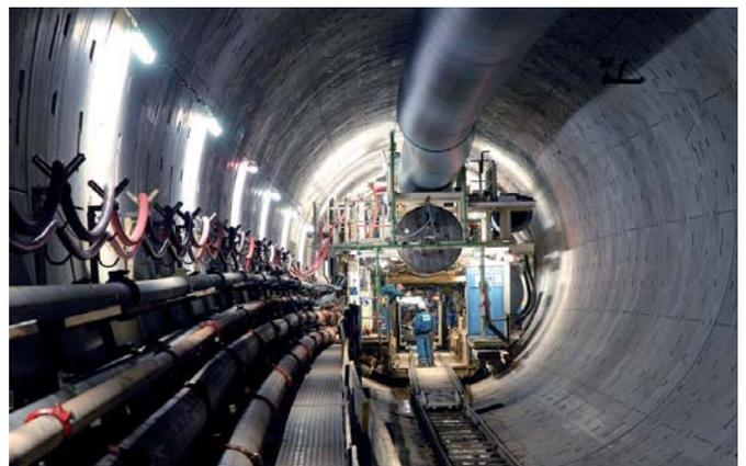
Schon bevor die Schildmaschinen in dem entsprechenden Bauabschnitt die Röhren auffahren, werden Maßnahmen zur Bodenverfestigung durchgeführt. Aus einem Kompensationsinjektionsschacht werden bis zu 55 Meter lange Rohre in unterschiedlichen Höhen fächerförmig in den Boden gebohrt. Durch diese wird an den erforderlichen Stellen Zementsuspension zur Stabilisierung des Erdreichs eingebracht.
