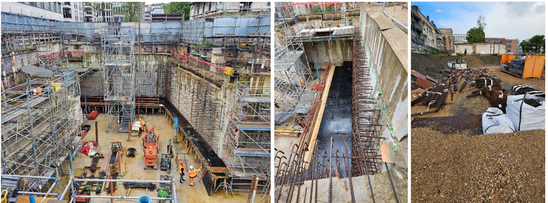
Drei Wände sind nun vollständig mit eingeklebten Anschlusseisen vorbereitet (Bild links). Die Montage der Schalung läuft bereits auf Hochtouren. Die erste Teillieferung der Bewehrung (Bild rechts) ist erfolgt und wurde vorsortiert gelagert.
