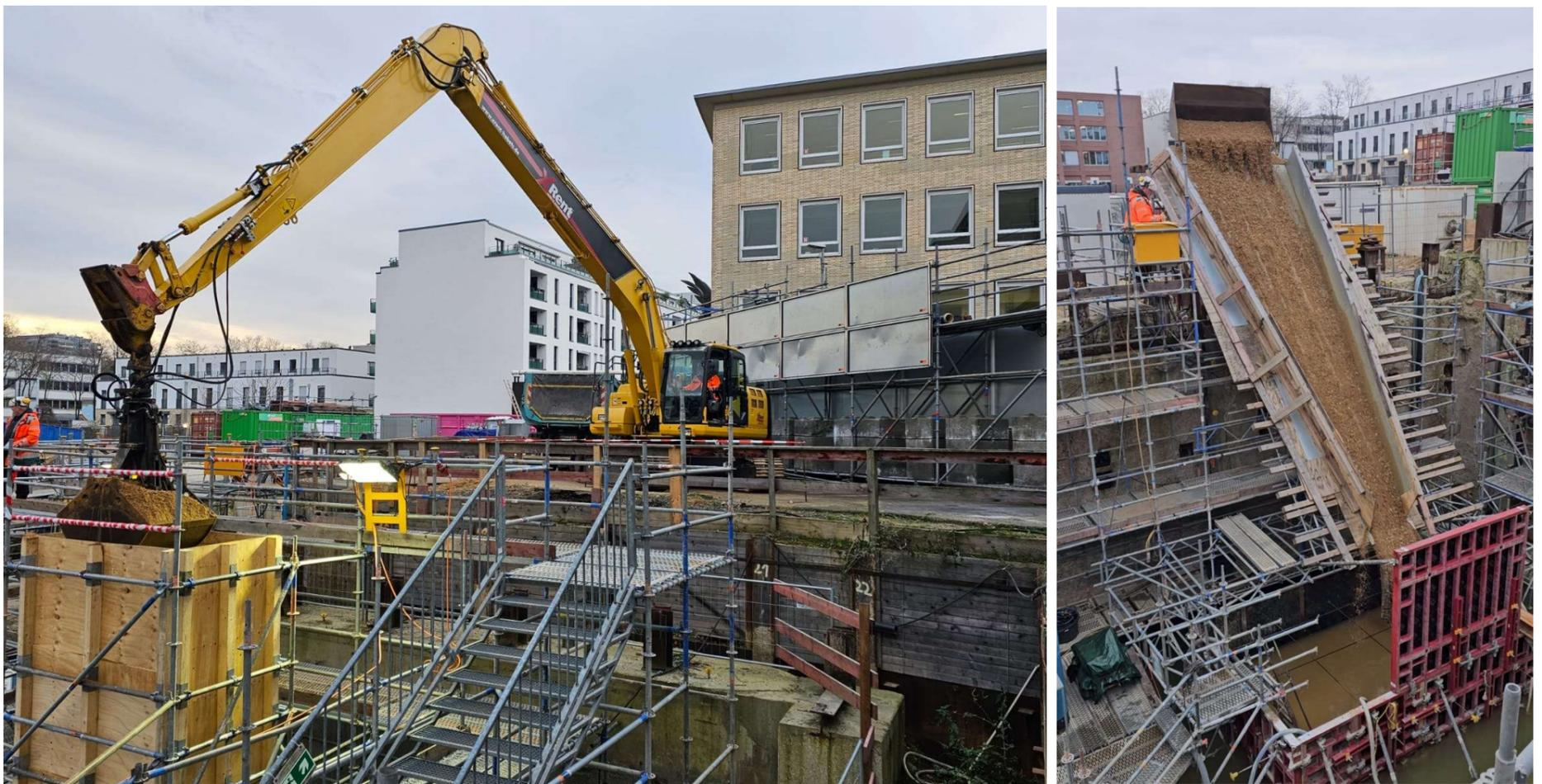
Die Kiesverfüllung der mittleren Bauwerksebene für das spätere Unterwerk hat in der vergangenen Woche begonnen. Das Stockwerk ist 5,50 Meter hoch und steht komplett unter Wasser. Aus statischen Gründen werden nun rund 3.200 Kubikmeter Kies bis in eine Höhe vom 3,50 Meter dort eingebracht.
