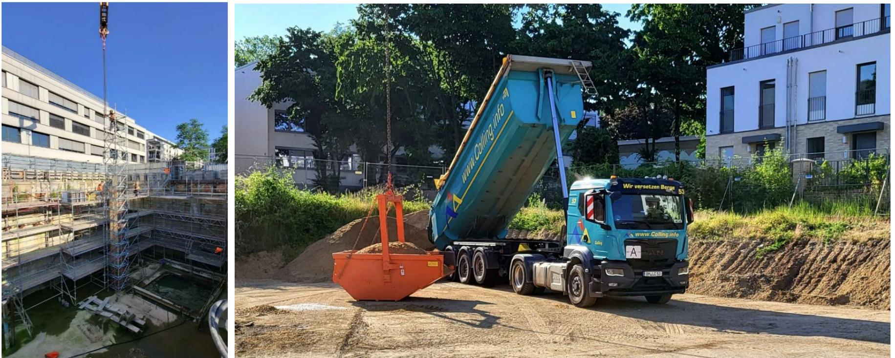
Die Umbauarbeiten für das Einbringen von Kies in das Gleiswechselbauwerk sind in vollem Gang. Der Kies dient als Auflast und wird über insgesamt vier sogenannte „Schütttürme“ eingebracht.
