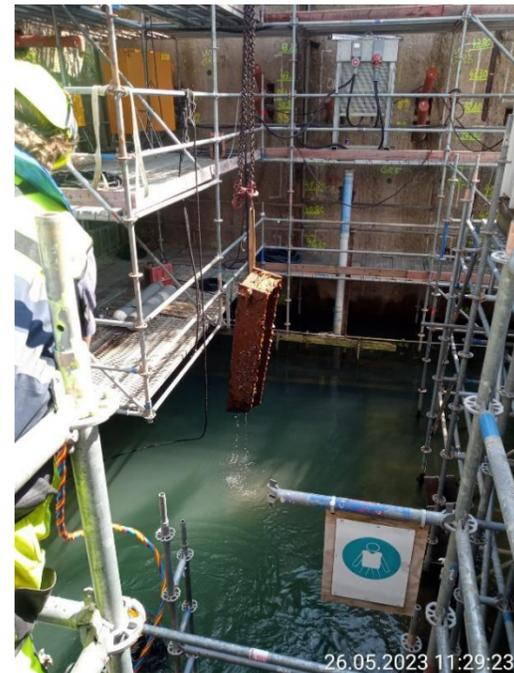
Die letzten Arbeiten zur Fugenertüchtigung gehen weiterhin gut voran. Der letzte Vergusstermin ist für den 07.06.2023 disponiert worden. Im linken Bild sieht man die Vergusstechnik durch einen Nachunternehmer der ARGE. Diese Technik ist deutschlandweit sehr rar, sodass die optimale Disposition der Termine sehr wichtig ist und hier auch gut funktioniert. Bei den fortlaufenden Vergussarbeiten an den Schlitzwänden wird die gleiche Technik zum Einsatz kommen.
