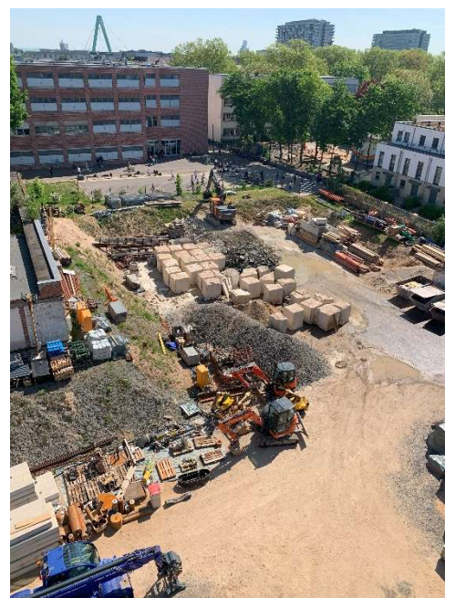
Die Abbrucharbeiten der Decke laufen in allen Bereichen auf Hochtouren (siehe Fotos links und Mitte). Weiterhin werden die Betonklötze auf dem Baufeld hydraulisch zerkleinert (Foto rechts).
