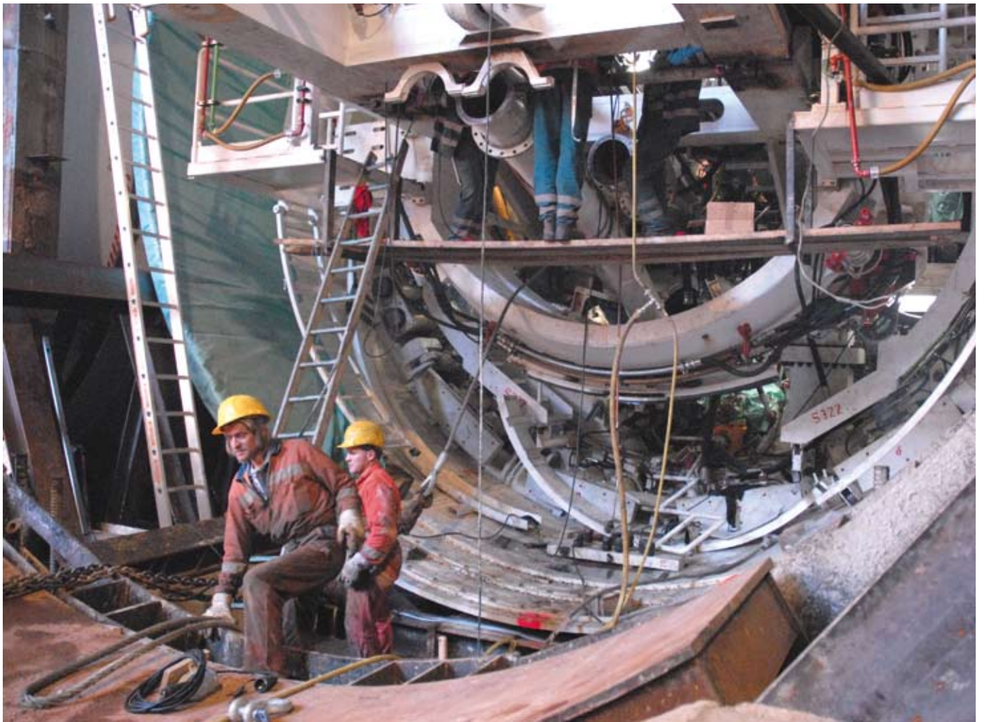
Zusammenbau der Tunnelbohrmaschine in der Baugrube.
