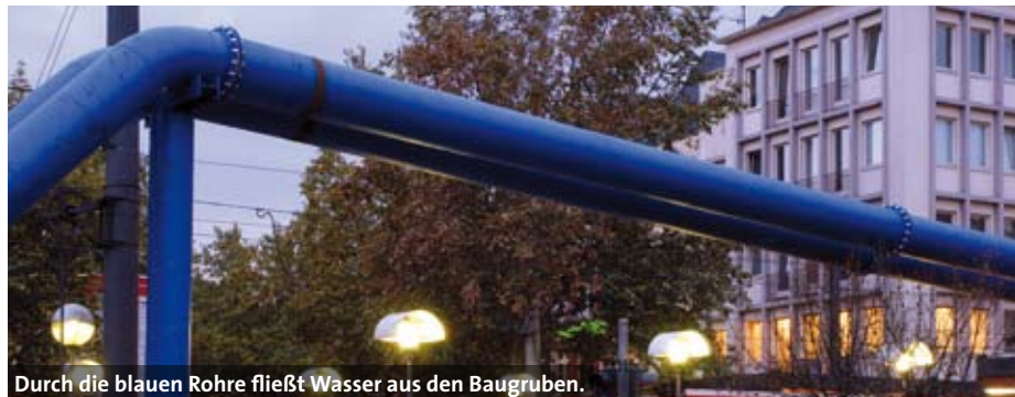
Durch die blauen Rohre fließt Wasser aus den Baugruben.
