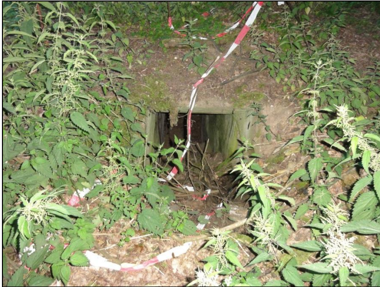
Abbildung 6: Bunkereingang (ca. 0,7 x 0,7 m) auf dem nördlichen KVB-Gelände
