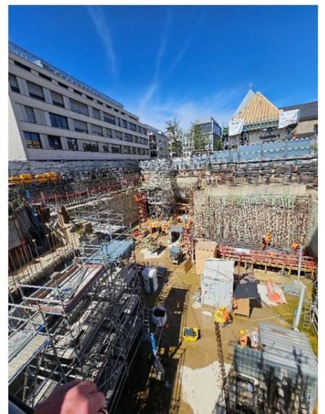
Die Bewehrung für die Vorsatzschale an Wand 3 wird diese Woche fertiggestellt; rechts unten ist ein Schaltisch zu sehen (Bild links). An Wand 1 (Bild Mitte) ist die Bewehrung bereits fertig. Anschließend kann die Schalung montiert werden. An den anderen Wänden werden die Schaltische vorbereitet (Bild rechts).
