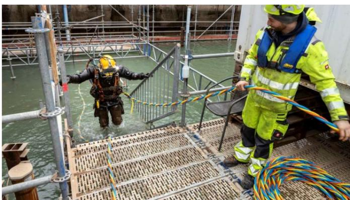
In den kommenden Monaten werden umfangreiche Erkundungen an der Schlitzwand durchgeführt. Dazu wird in einem ersten Schritt die Schlitzwand von anhaftenden, losen Materialien mittels Hochdruckreiniger befreit. Diese Arbeiten werden unter Wasser durch mehrere Taucher-Teams ausgeführt.
